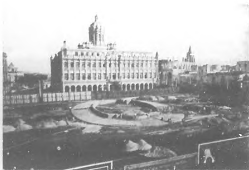
Vista de las obras en construcción del parque "Alfredo Zayas", al fondo del Palacio Presidencial.
